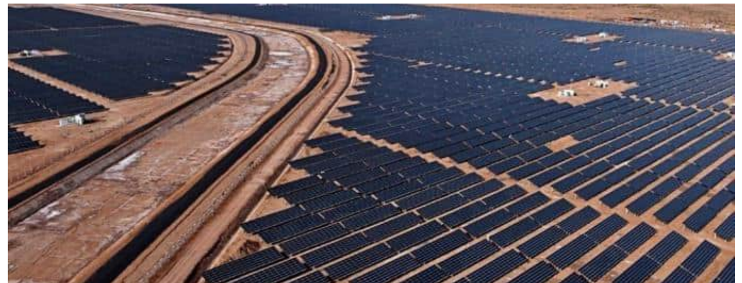
Centrale photovoltaïque au sol de Kamuthi, Inde
